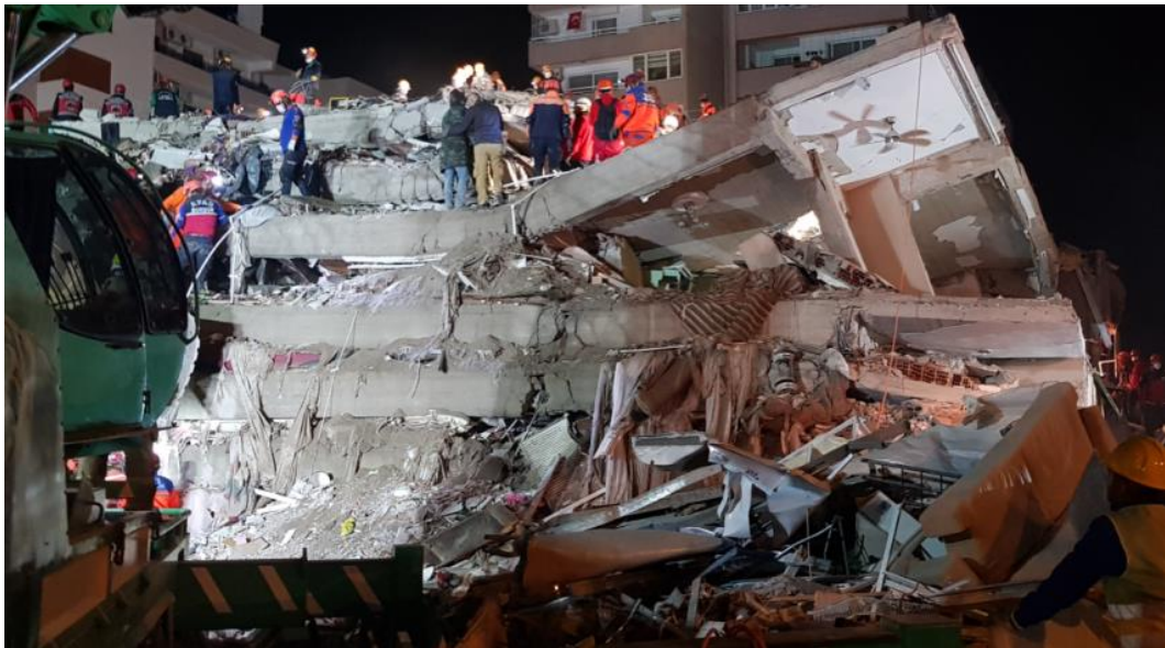
Şekil 3.8 – Rıza Bey Apartmanı'nın enkazı (çapraz görünüm)
