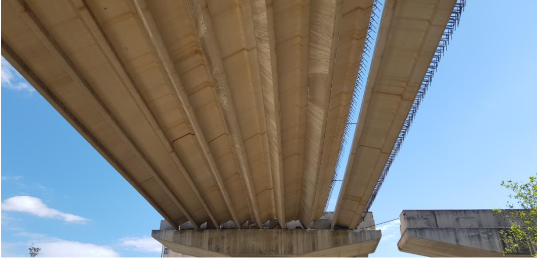
Şekil 4.5 – Başlık kirişi üzerinde kalan yan yatmış kirişler
