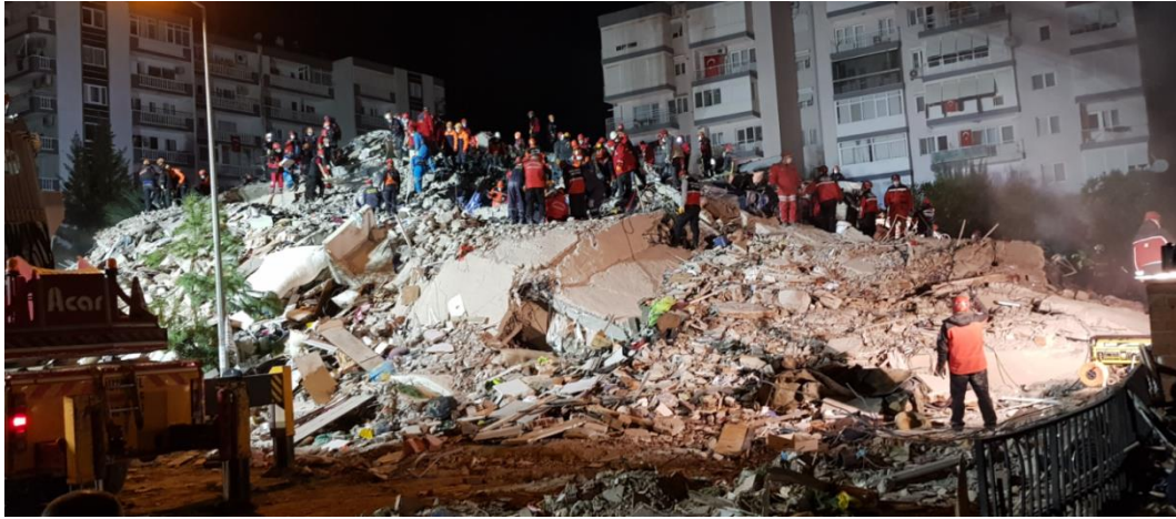
Şekil 3.20 – Emrah Apartmanı'nın enkazı (çapraz görünüm)
