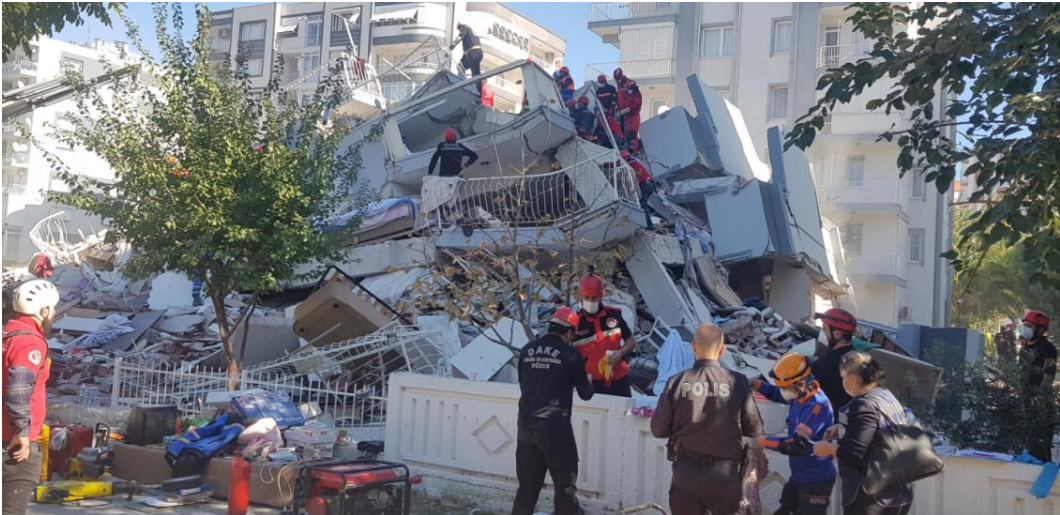
Şekil 3.28 – Yağcıoğlu Sitesi B Blok'un enkazı (çapraz görünüm)
