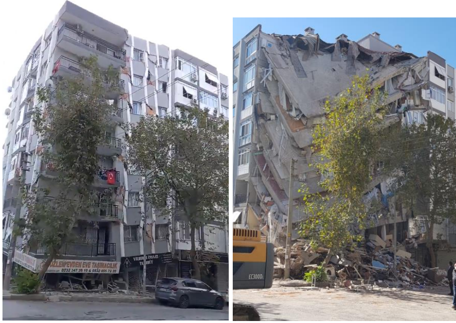
Şekil 3.68 – Karagül Apartmanı'nın göçme anı ve sonrası (Posta, 2020)
