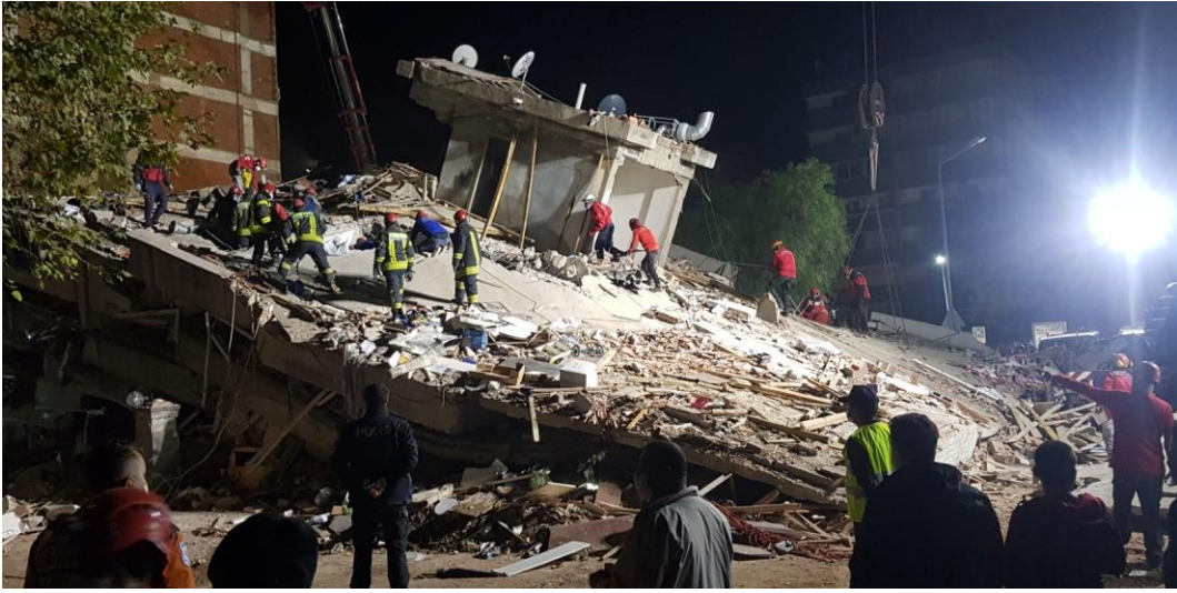
Şekil 3.13 – Doğanlar Apartmanı'nın enkazı (çapraz görünüm)
