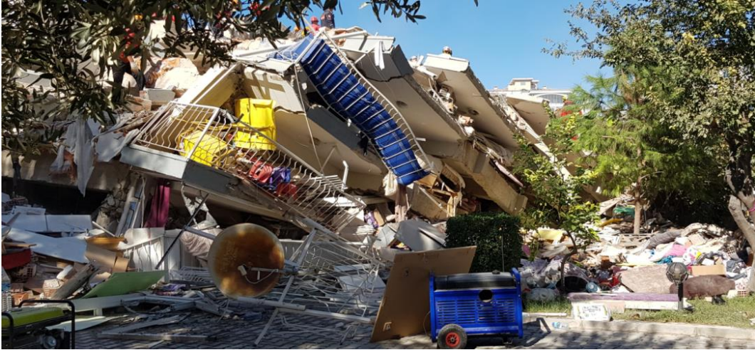
Şekil 3.30 – Yağcıoğlu Sitesi B Blok'un enkazı (çapraz görünüm)
