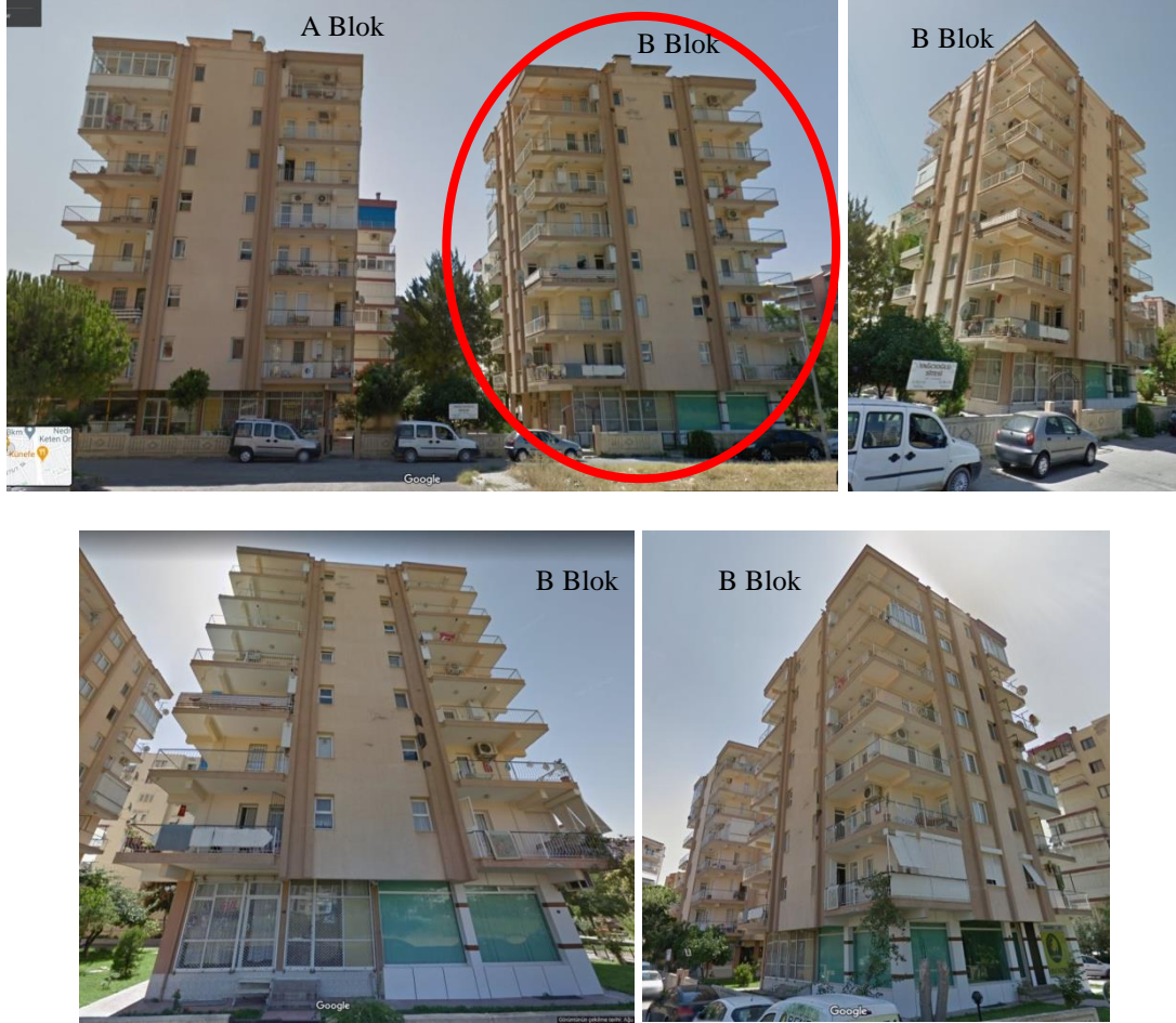
Şekil 3.25 – Yağcıoğlu Sitesi B Blok'un yıkılmadan önceki görünümü (Google Maps, 2020)
