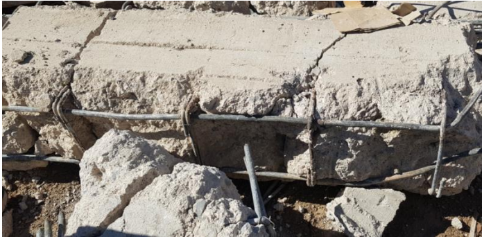
Şekil 3.23 – Emrah Apartmanı'ndaki bazı yapısal elemanların donatı detayları
