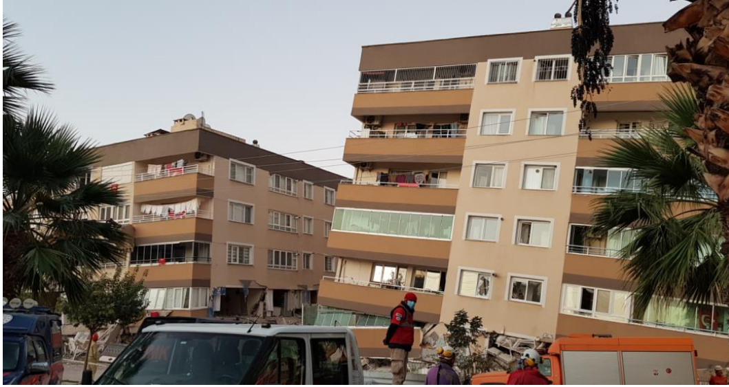
Şekil 3.44 – Barış Sitesi enkazı (ön görünüm)
