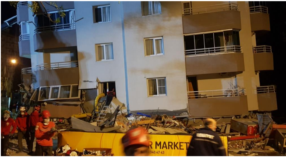
Şekil 3.35 – Yılmaz Erbek Apartmanı Kuzey Blok'un enkazı (yan görünüm)
