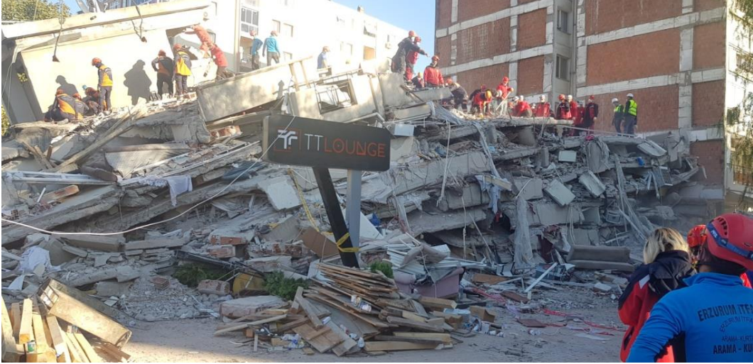
Şekil 3.16 – Doğanlar Apartmanı'nın enkazı (yan görünüm)
