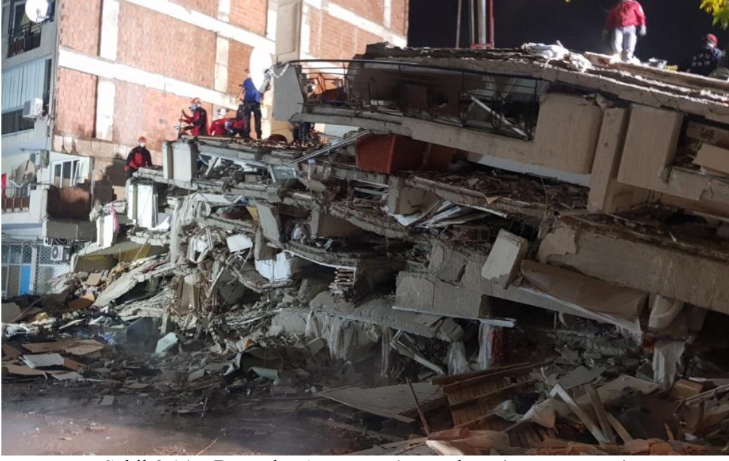
Şekil 3.14 – Doğanlar Apartmanı'nın enkazı (yan görünüm)
