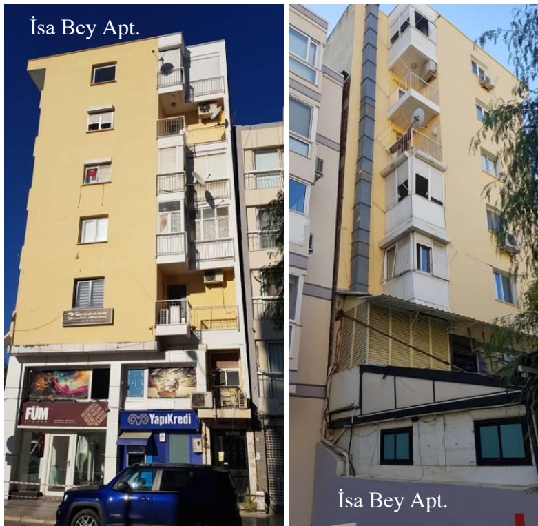
Şekil 3.54 – Ayrılan ve yana yatan binalar
