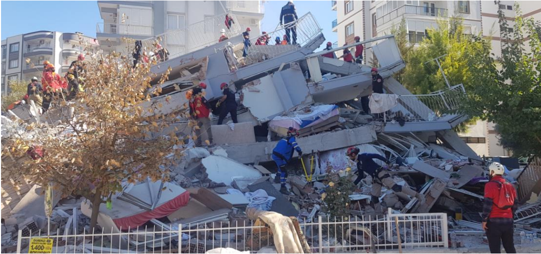
Şekil 3.27 – Yağcıoğlu Sitesi B Blok'un enkazı (yan görünüm)
