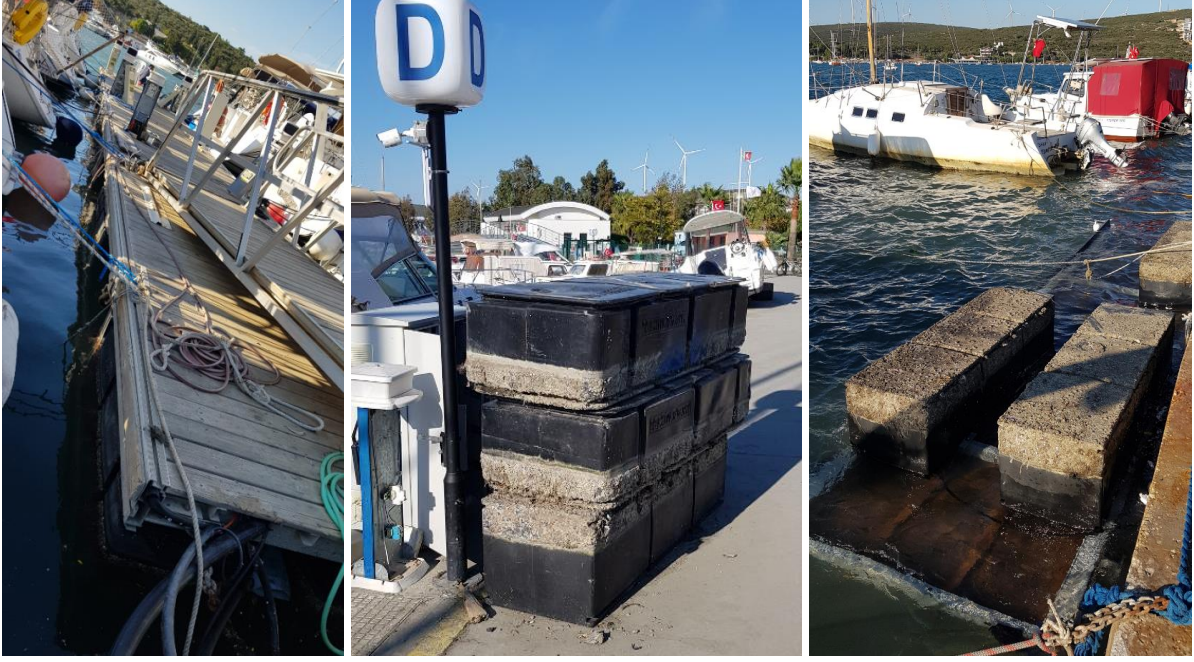
Şekil 5.3 – Kopmuş ve hasar almış pantonlar
