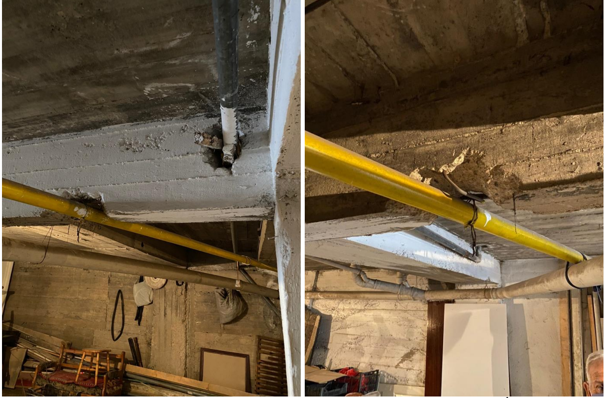
Şekil 3.75 – Kullanım aşamasında kirişe verilen hasarlar (Karşıyaka, İzmir)
