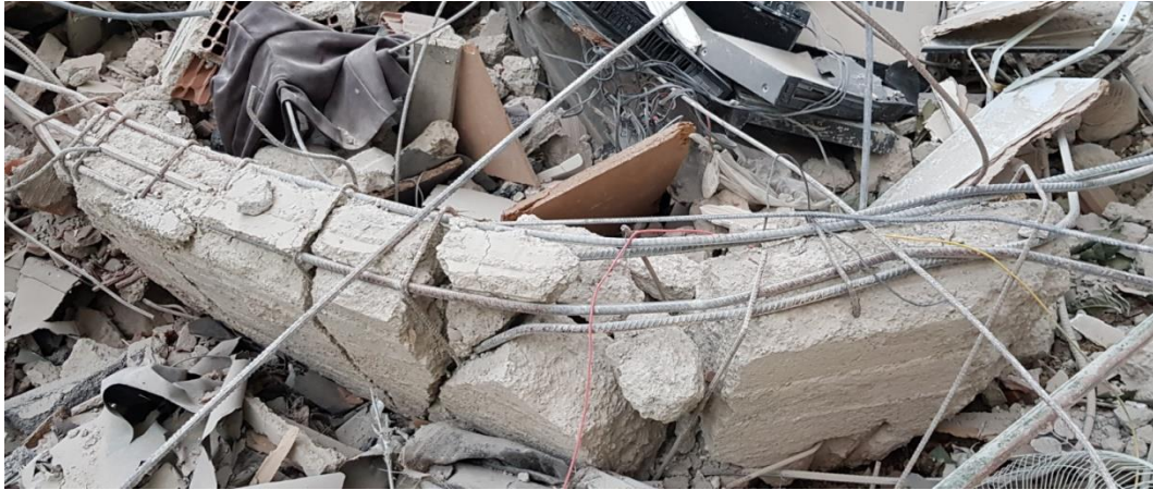
Şekil 3.38 – Yılmaz Erbek Apartmanı Kuzey Blok'una ait bir kolonu
