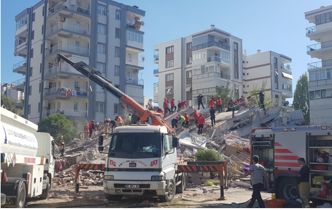
Şekil 3.26 – Yağcıoğlu Sitesi B Blok'un enkazı (çapraz görünüm)
