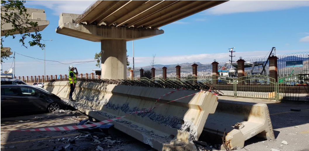
Şekil 4.4 – Düşen kirişlerin görünümü (3)
