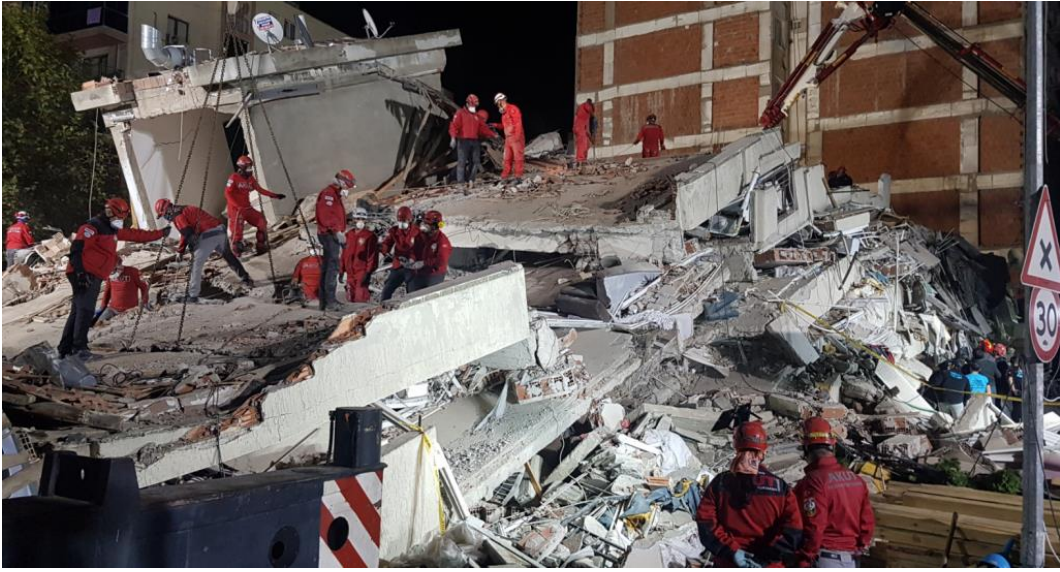
Şekil 3.15 – Doğanlar Apartmanı'nın enkazı (çapraz görünüm)
