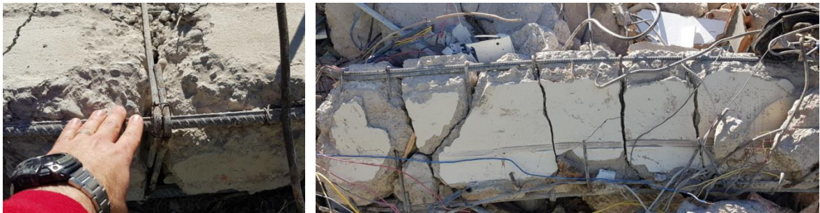
Şekil 3.31 – Yağcıoğlu Sitesi B Blok'taki bazı yapısal elemanlarındaki donatı detayları
