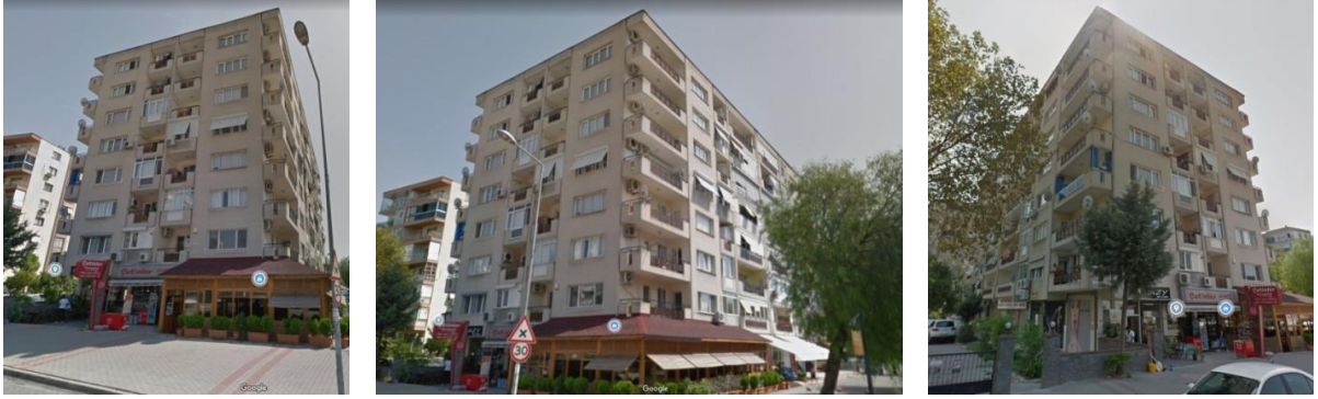
Şekil 3.12 – Doğanlar Apartmanı'nın yıkılmadan önceki görünümü (Google Maps, 2020)
