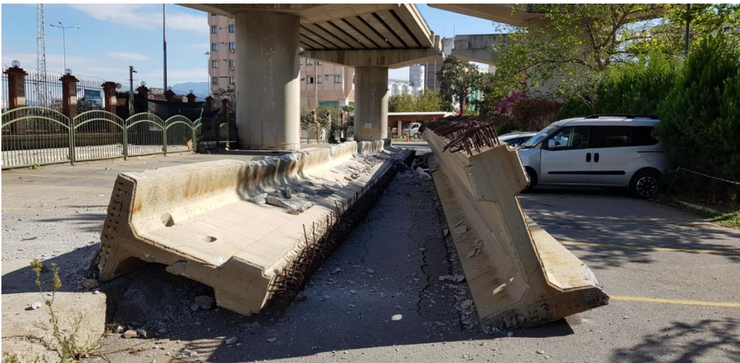
Şekil 4.2 – Düşen kirişlerin görünümü (1)
