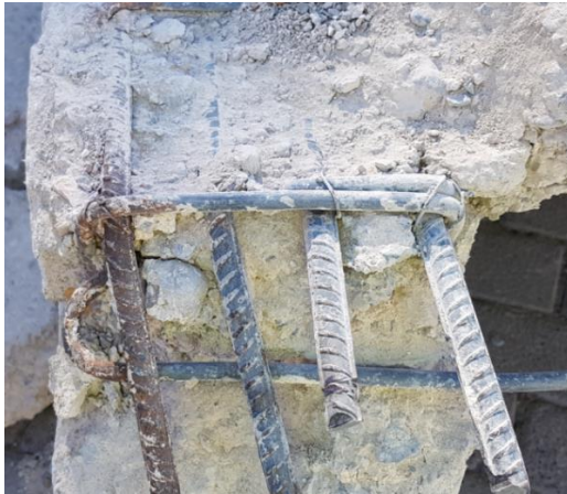
Şekil 3.10 – Rıza Bey Apartmanı'ndaki bazı elemanların beton ve donatı detayları
