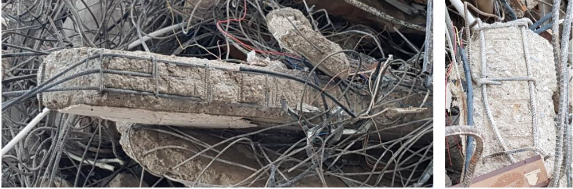
Şekil 3.37 – Yılmaz Erbek Apartmanı Kuzey Blok'ta yer alan bazı yapısal elemanlarındaki donatı detayları
