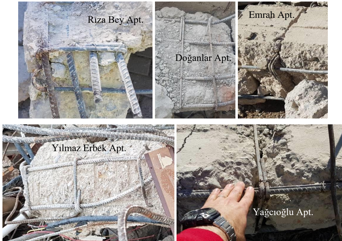
Şekil 3.64 – Yıkılan binaların etriyelerinin büküm şekilleri
