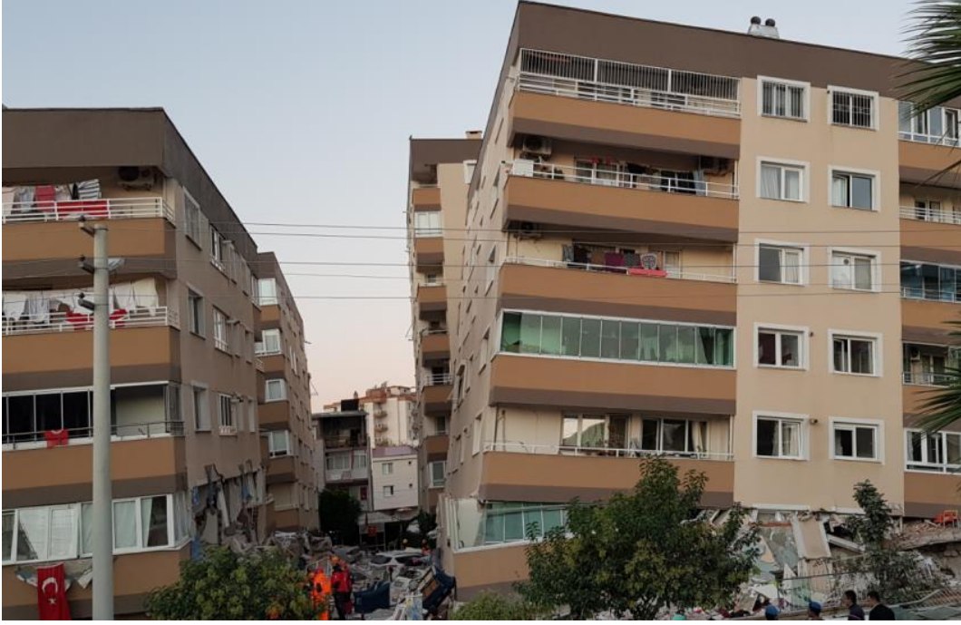
Şekil 3.45 – Barış Sitesi enkazı (ön görünüm)
