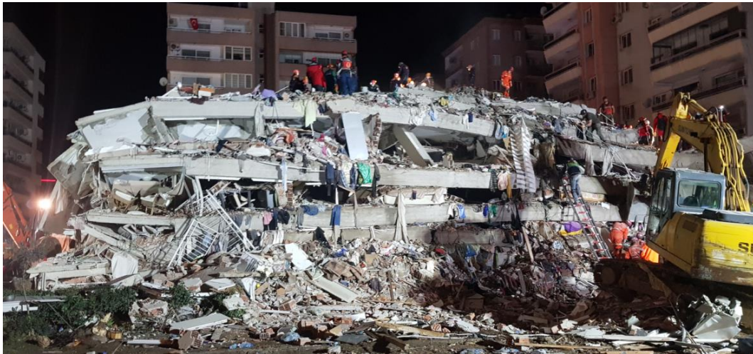
Şekil 3.5 – Rıza Bey Apartmanı'nın enkazı (ön görünüm)
