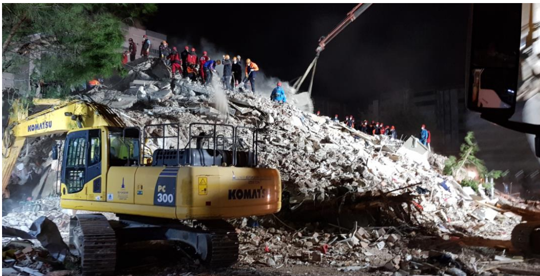
Şekil 3.21 – Emrah Apartmanı'nın enkazı (çapraz görünüm)
