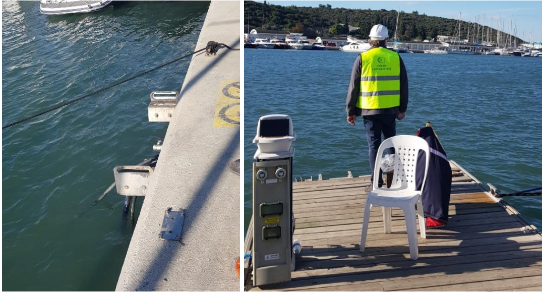
Şekil 5.4 – Panton kopma bölgeleri
