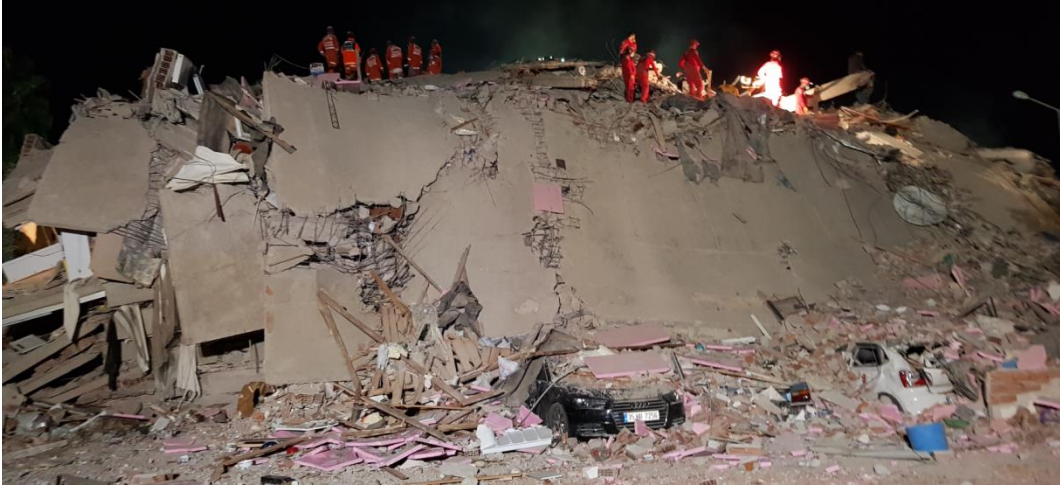
Şekil 3.7 – Rıza Bey Apartmanı'nın enkazı (yan görünüm)
