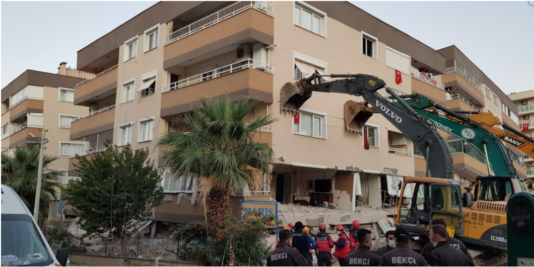
Şekil 3.46 – Barış Sitesi enkazı (çapraz görünüm)
