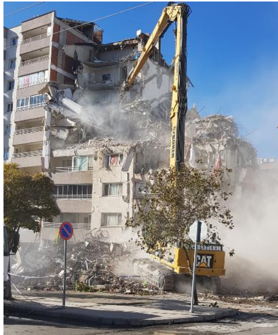
Şekil 3.36 – Yılmaz Erbek Apartmanı Kuzey Blok'un yıkımı
