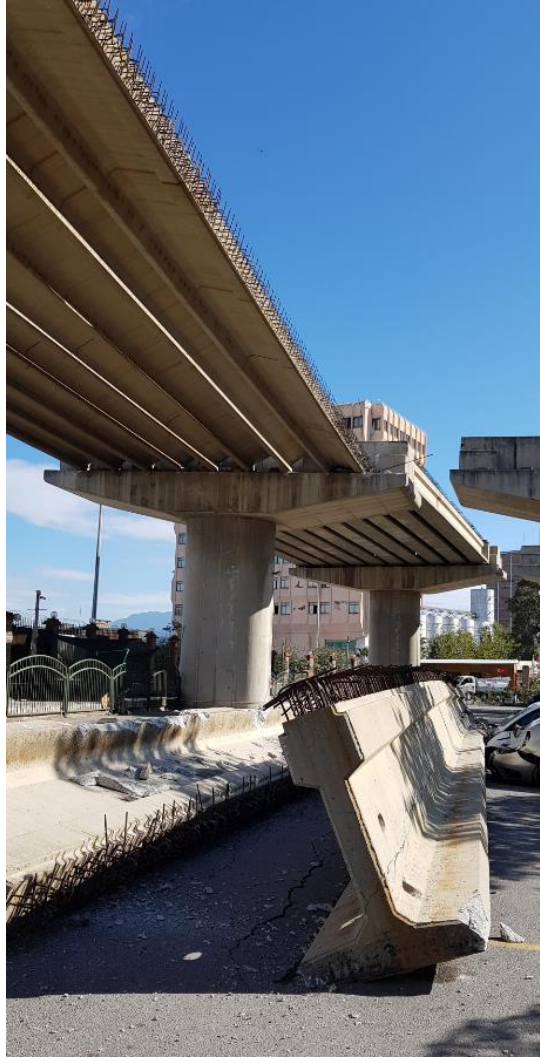
Şekil 4.3 – Düşen kirişlerin görünümü (2)
