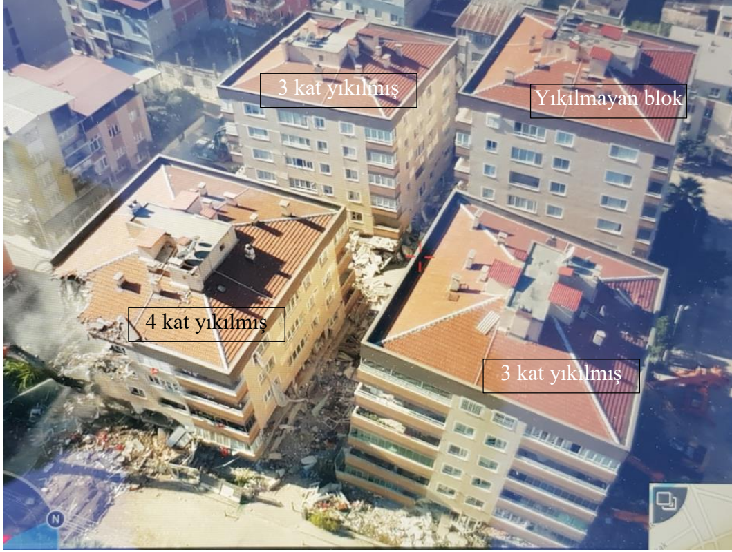
Şekil 3.43 – Barış Sitesi enkazı (uçangöz görünümü)
